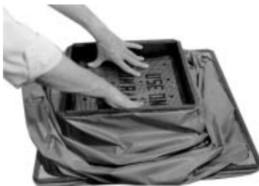
Figura 6: Instalación de la rejilla LoFlow
